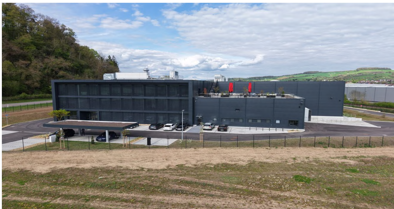
Neubau Wutöschingen 2026 · Dachterrasse und PV-Anlage
